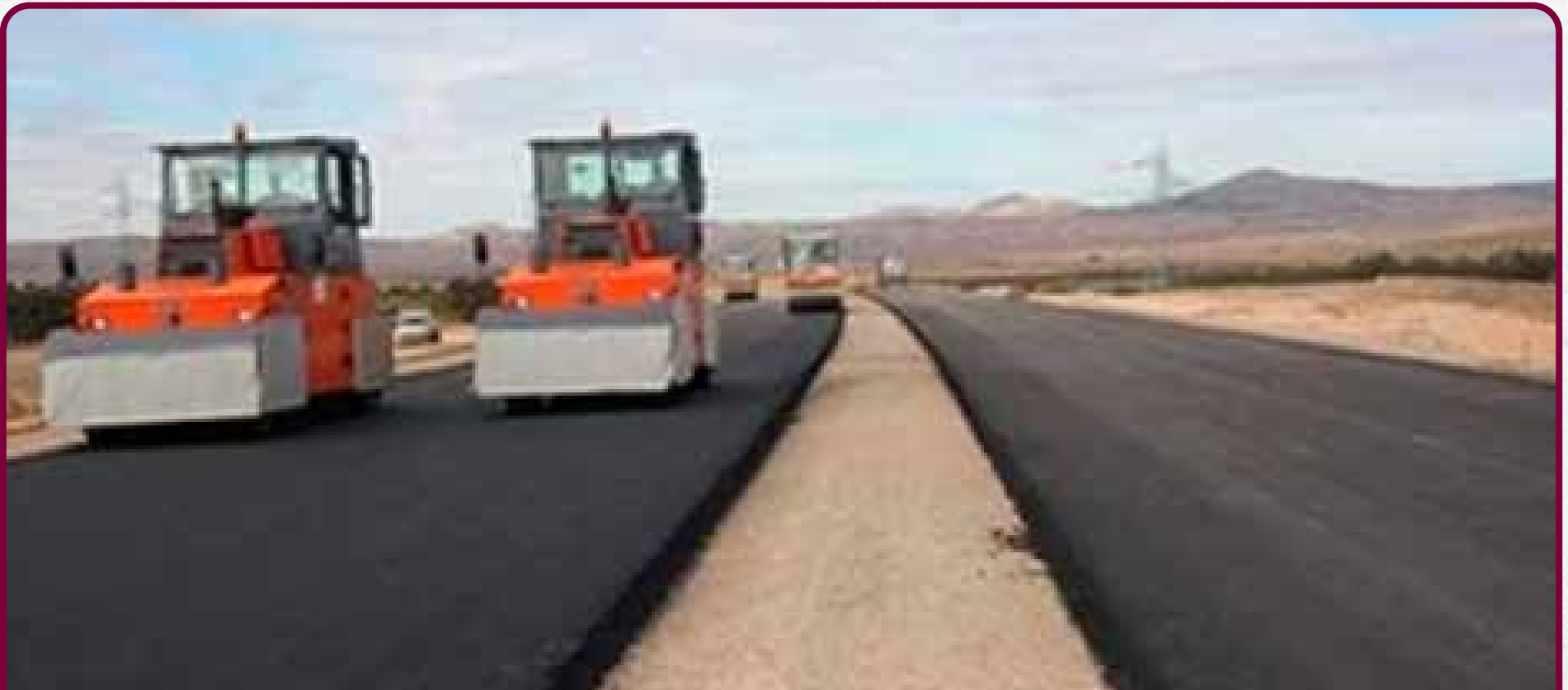
أشغال الطريق السريع تيزنيت - الداخلة
